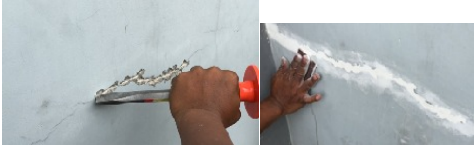
Gambar 2: Proses membuka retakan dan mengaplikasikan campuran bonding agent TR-30 + MP-40
