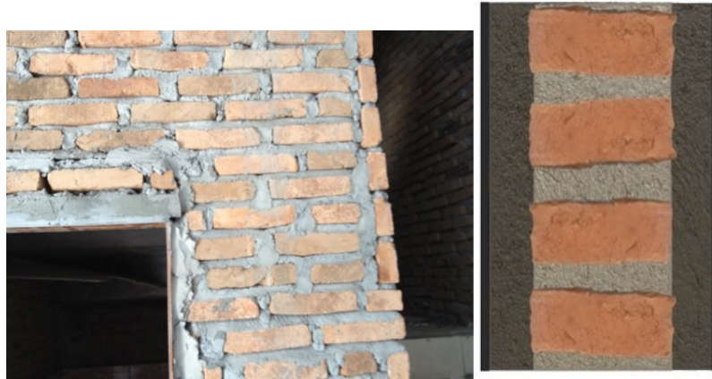
Gambar 3: Kualitas rendah pada pasangan bata tradisional dibandingkan dengan mortar
