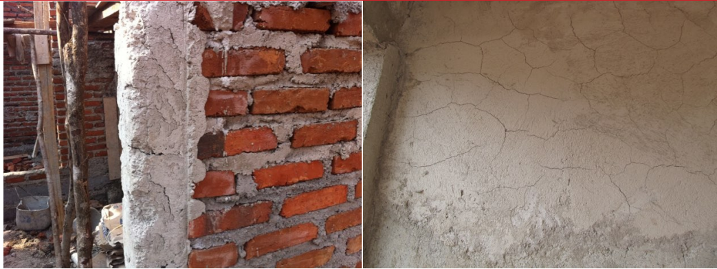
Gambar 6: Konstruksi berkualitas rendah — pasti tidak tahan lama!
