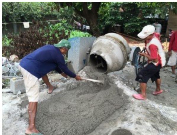
Gambar 4: Pencampuran adukan menggunakan molen untuk hasil yang homogen
