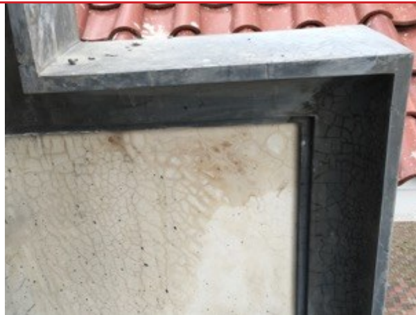
Gambar 7: Detail waterproofing pada kusen jendela
