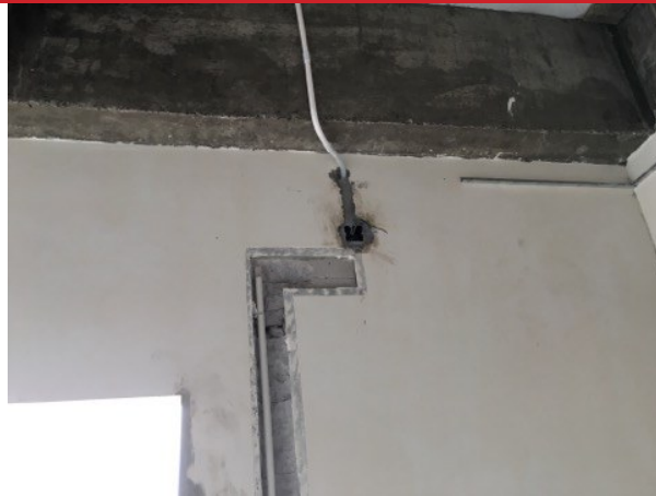
Gambar 5: Saluran konduit yang sudah terpasang sebelum plester
