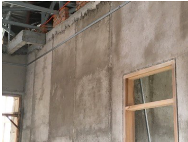
Gambar 3: Kusen jendela dan pintu terpasang sebelum plester, untuk hasil perataan terbaik
